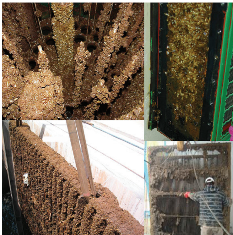
Imagen 55: Macrofouling del mejillón dorado en el filtro de inicio de un sistema de refrigeración de una central hidroeléctrica (A); macrofouling en un intercambiador de calor de una central hidroeléctrica (B); rejas para peces con macrofouling en centrales termoeléctricas (C y D).
